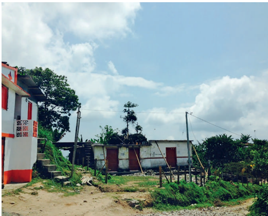
Figura 10. Casas abandonadas en vereda Juan Tapao.
