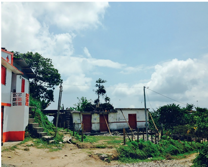
Figura 10. Casas abandonadas en vereda Juan Tapao.
